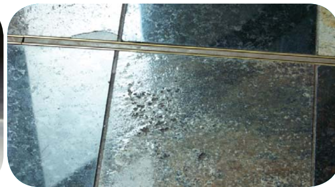
SPALLING
